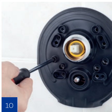
Szerelőlap rögzítése
